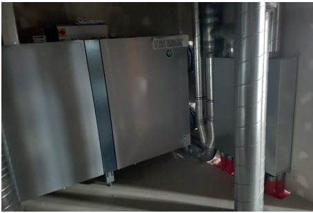
Vallox Vario 1500 CC als Standgerät verbaut
